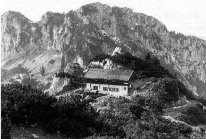
Abb. 2: Ansicht der Kampenwandhütte 1920 (Quelle: http://www.alpenverein-muenchen-oberland.de/huetten_wege/selbstversorgerhuetten/uebersicht/kampenwandhuetten/geschichte/ ).
