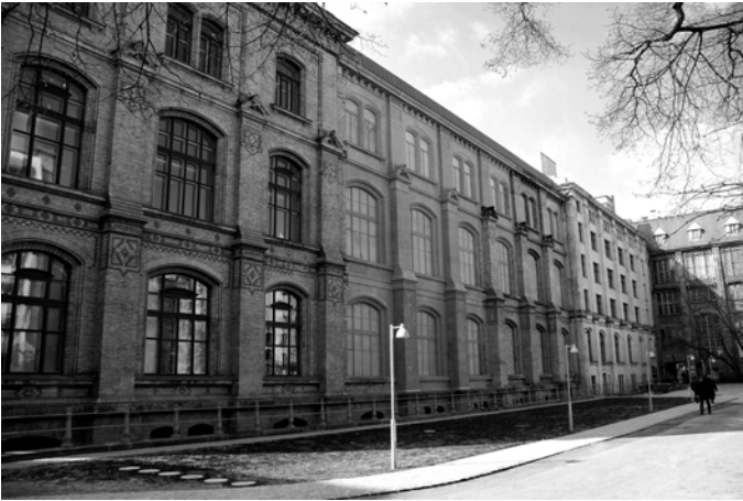
Abb. 2: Der wieder aufgebaute Ostflügel des Museums für Naturkunde im März 2011. Man beachte die raffiniert gefertigten massiven Beton-Fenster-Fassadenteile (hellgrau in der Bildmitte) zwischen der 1. und 2. Laterne, die den völlig niedergebombten Mittelteil „illusionistisch“ ergänzen. Foto: FRANK TILLACK.
